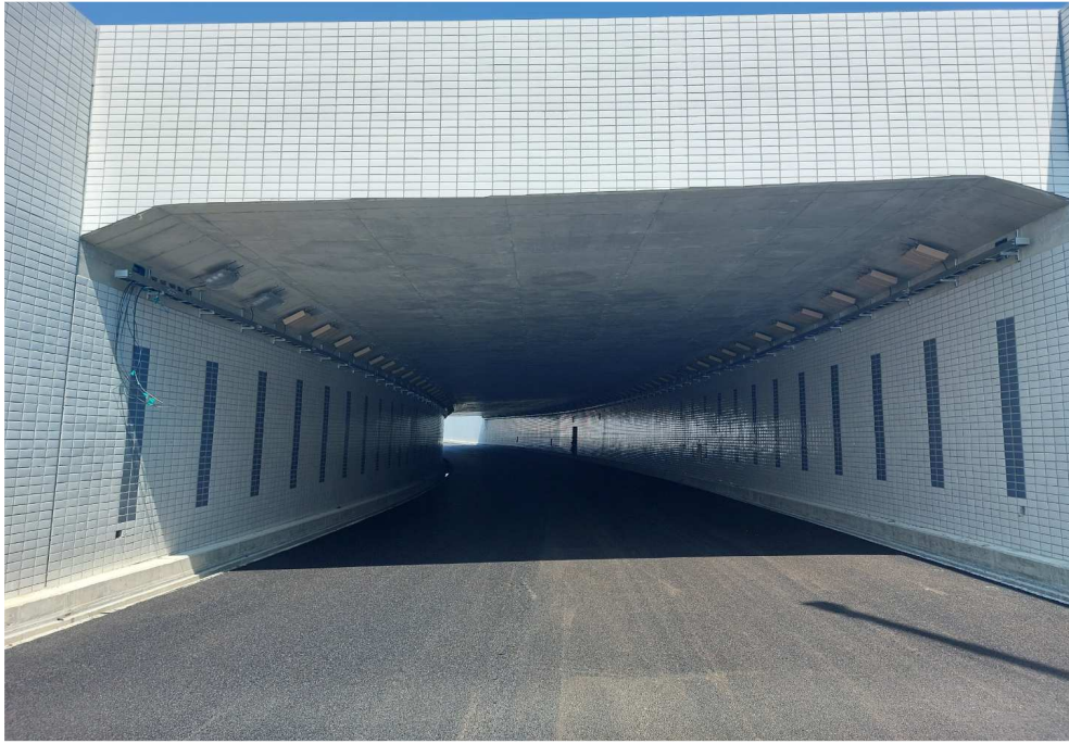
시점부 지하차도#1 전경
