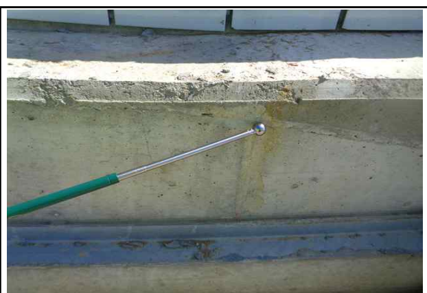
들뜸봉을 이용한 외관조사(타격음)
