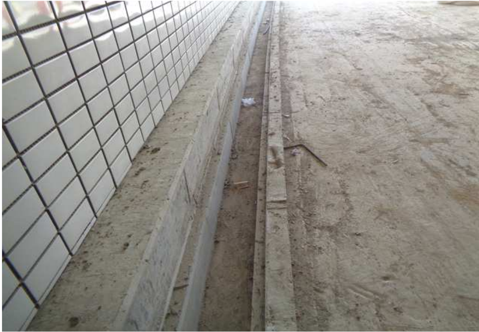
지하차도#1 배수로 전경
