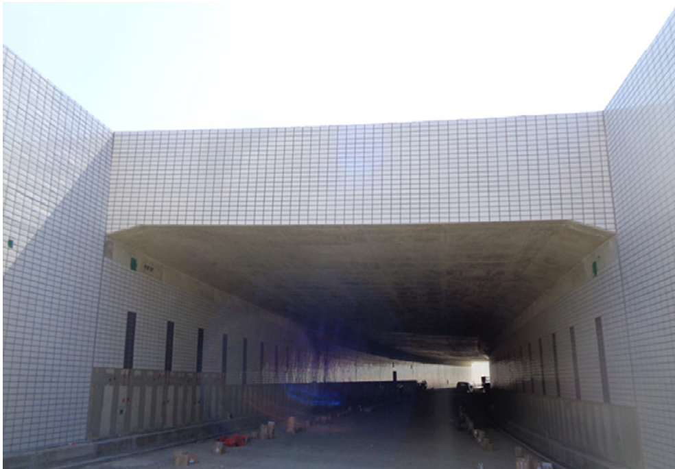
종점부 지하차도#1 전경
