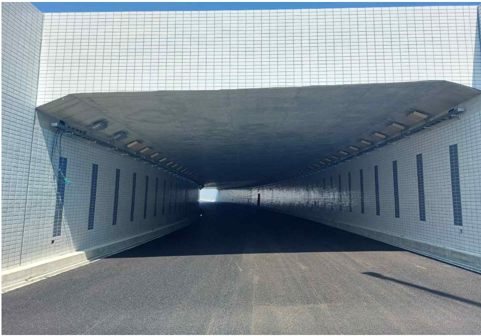
시점부 지하차도#1 전경
