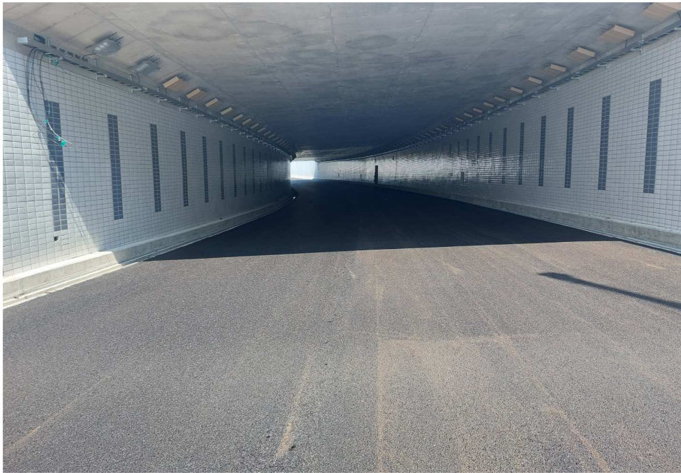
지하차도#1 벽체, 포장 전경
