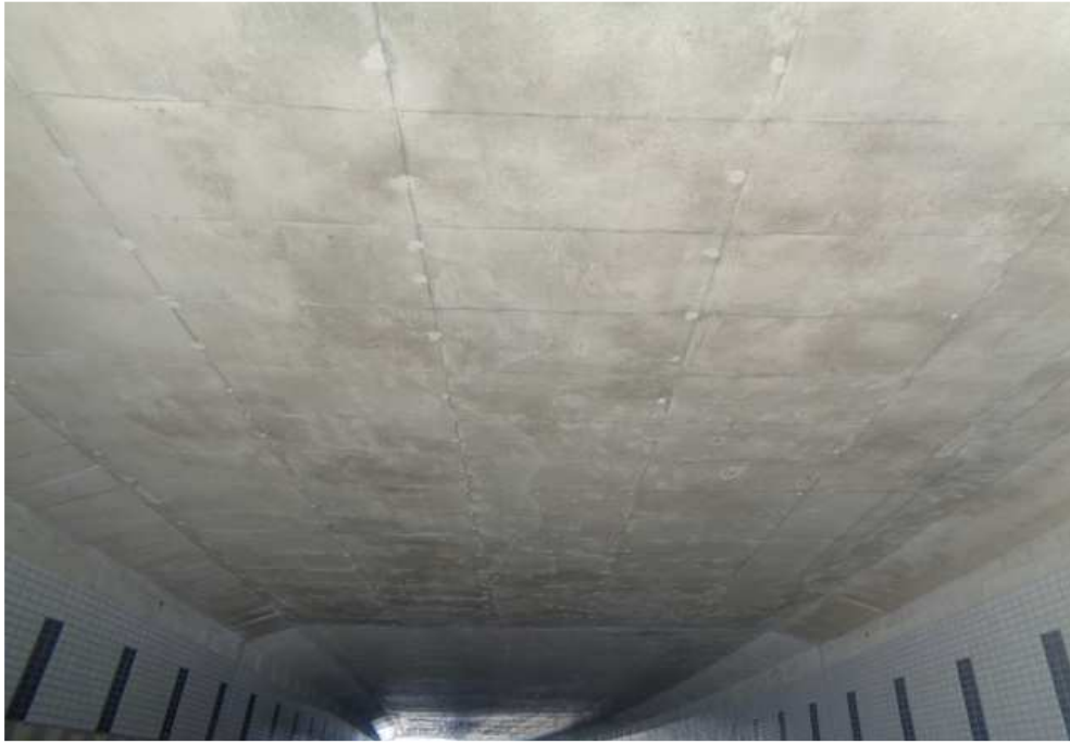
지하차도#1 상부슬래브 전경
