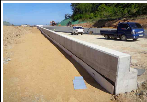
외측 콘크리트 상태양호
